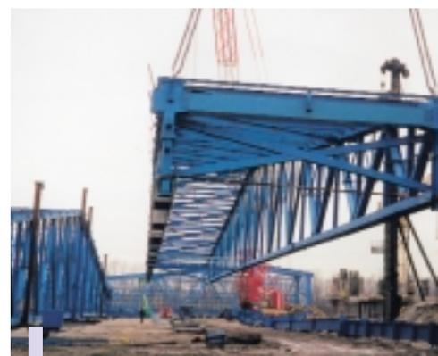
An Doppelunterflaschenhaken wurde das 390 Tonnen schwere Stahlgestell gleichmäßig auf Transporthöhe gebracht.
